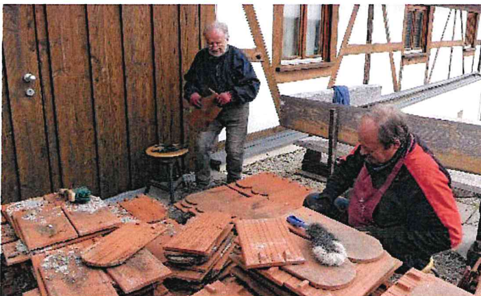
Neues Dach für die Küche der Kelter
