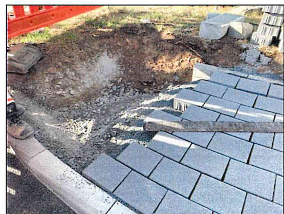
erkennbar: mit Vorsatz geformte Betonsteine
