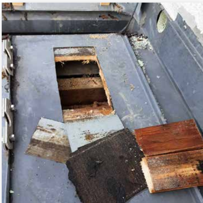
Blick in die Konstruktion
